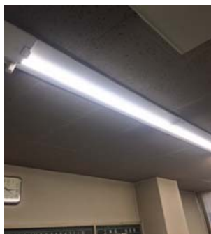
LED電球へ変更(1F及び2F)
