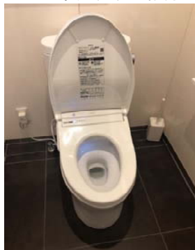
トイレ改修(節水型)
