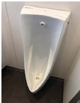
トイレ改修(節水型)
