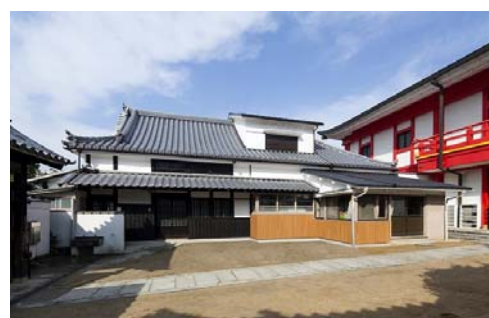
正善寺庫裏改修工事
