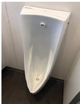
トイレ改修(節水型)
