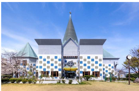
伊丹市立サンシティホール大規模改修工
