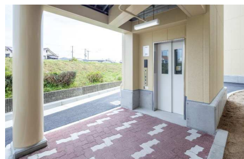
市営玉田団地エレベーター設置工事
