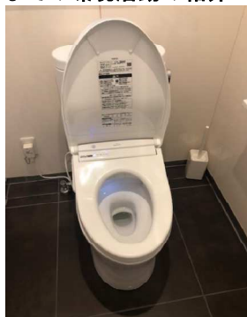
トイレ改修(節水型)
