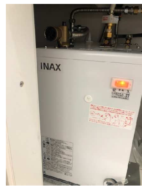
ガス給湯器から電気温水器へ変更
