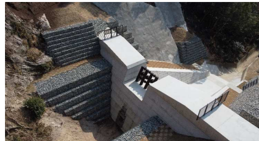
青山第四砂防堰堤工事
