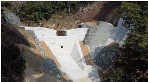
青山第四砂防堰堤工事
